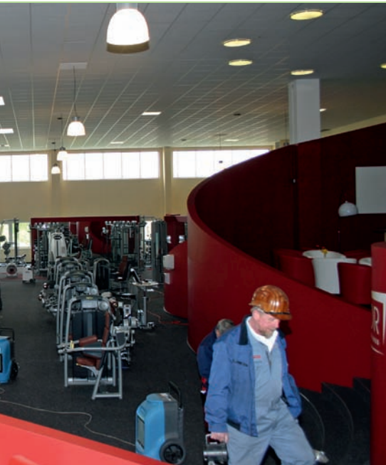
Bild 5 | Auch weiter entfernte Räume waren in Mitleidenschaft gezogen.
